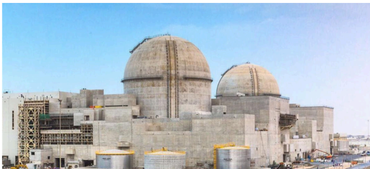
RYŚ. 5.3 Elektrownia Barakah w budowie (2017). Obudowy bezpieczeństwa – grube na około metr powłoki z żelbetu – zostaną z reaktorami przez całe ich życie.
