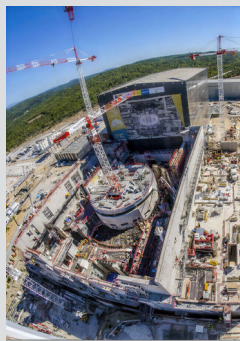
Plac budowy ITER w Cadarache we Francji, 2017 r.
