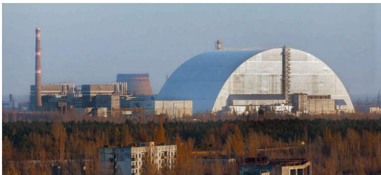
RYŚ. 11.2 Nowa Bezpieczna Powłoka nad zniszczonym reaktorem w Czarnobylu – stalowa arka wzniesiona wspólnym wysiłkiem blisko pięćdziesięciu państw i zaprojektowana na sto lat. Pod jej osłoną trwa demontaż starego sarkofagu.
